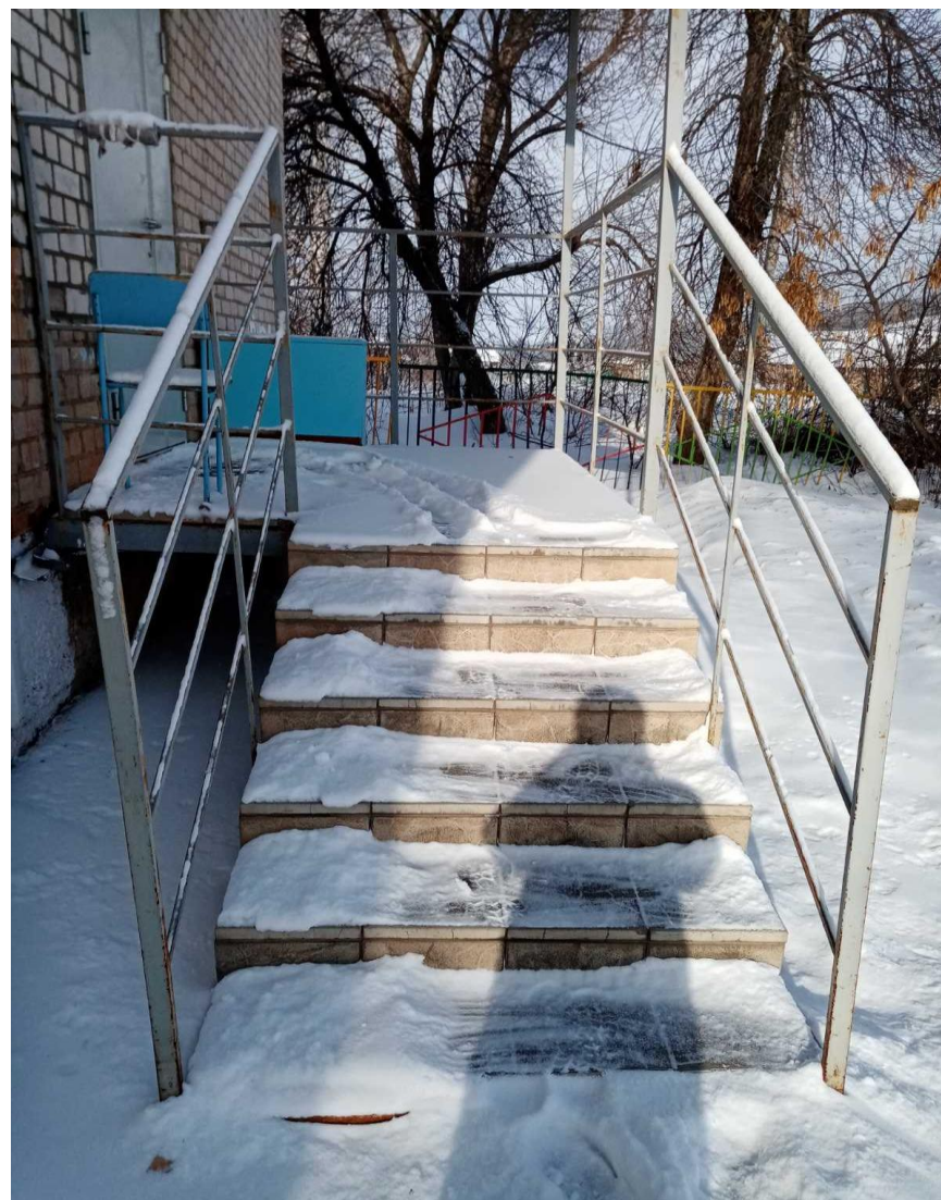
Фото №3 Лестница наружная (вход в здание)
