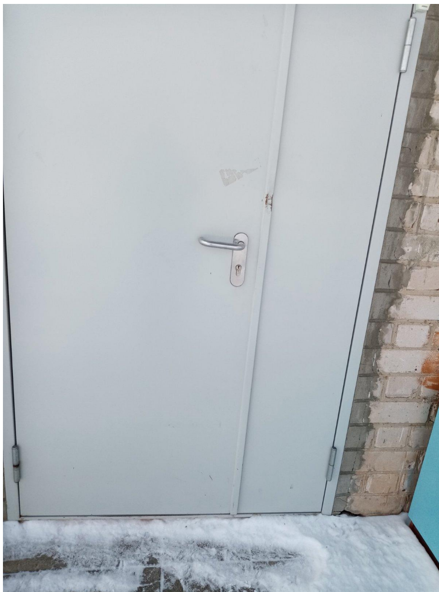
Фото №4 Входная площадка, дверь
